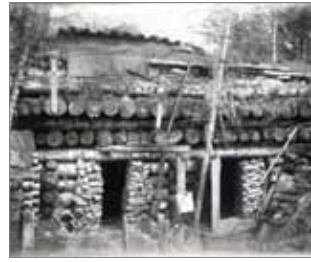
La Tête des Faux (Haut-Rhin), abri de tranchée. Doc. J.-C. Fombaron
