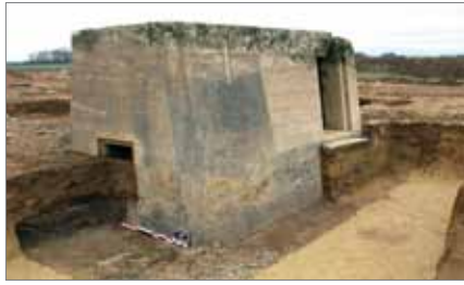
Position fortifiée de Geispolsheim (Bas-Rhin) : petit abri bétonné. Photo: M. Landolt, Pair
