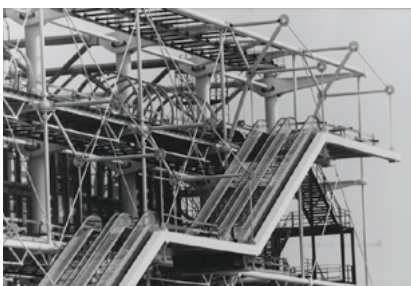
Le chantier du Centre Pompidou, années 1970, photographie non identifiée
