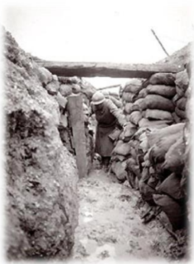
Tranchée à Craonne...
