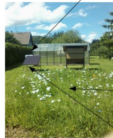
Panneau solaire qui alimente la pompe de la cuve d'eau de pluie
