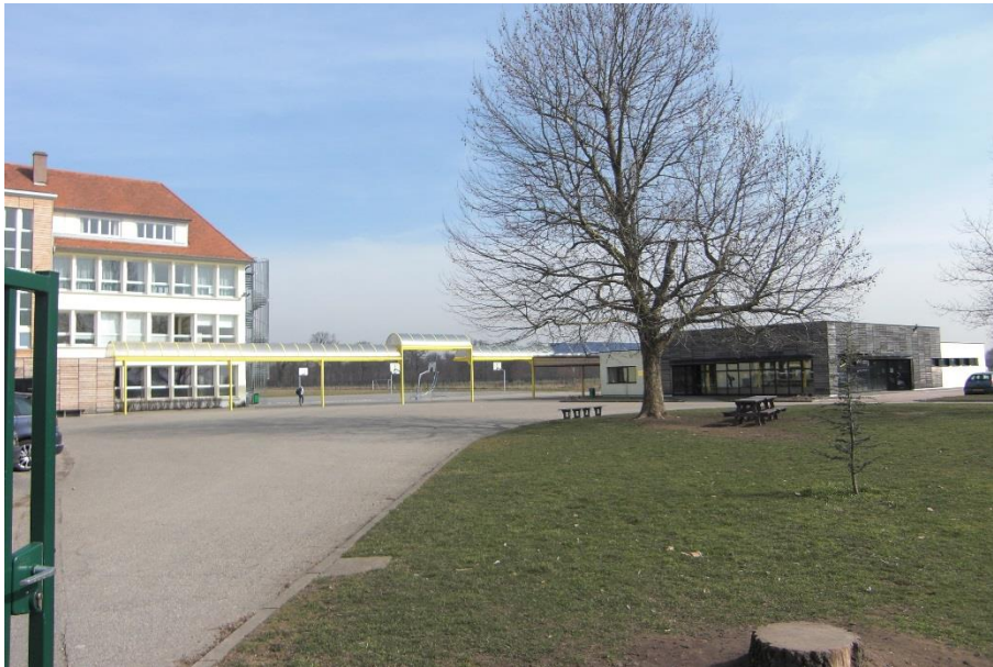
L'ancien bâtiment et le plus récent bioclimatique
