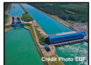
EDF usine de Rhinau
