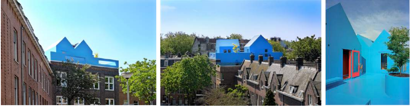
ROTTERDAM, Pays-Bas : Didden Village, La Maison bleue, 2006, architecte Winy MAAS (MVRDV).
