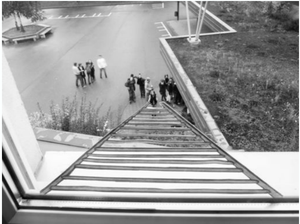
Une échelle pour accéder à la salle depuis la cour
