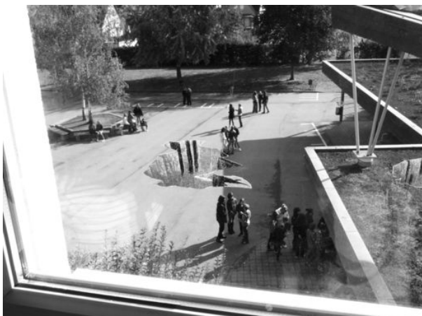
Une crevasse au milieu de la cour de récréation
